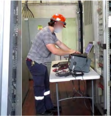
Réalisation de tests
