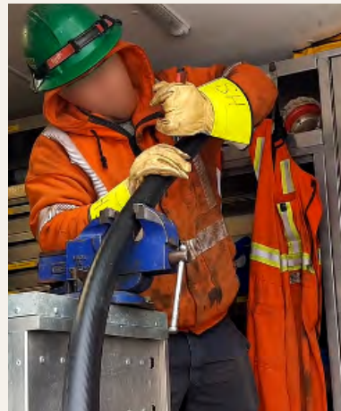
Dénudage d'un câble
