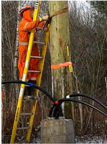
Installation d'une ligne de poulie
