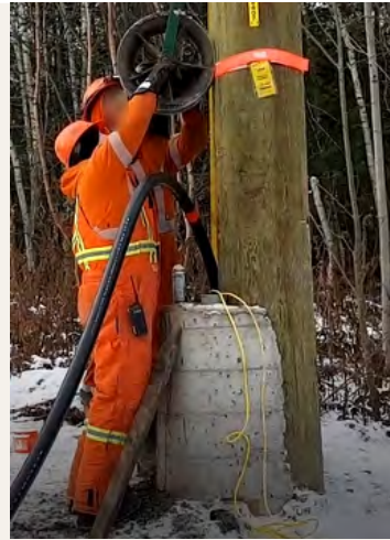
Installation d'une ligne de poulie – levage à deux personnes
