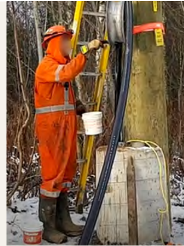
Lubrification d'un câble
