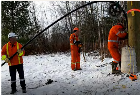
Installation d'une ligne de poulie
